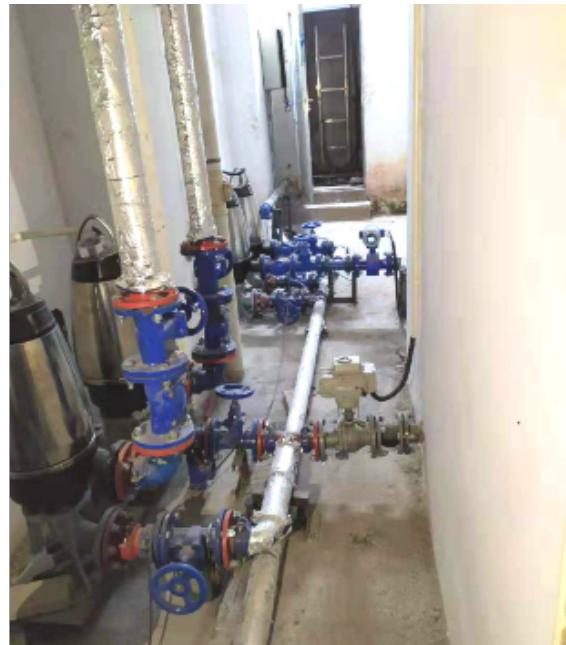
核医学放射性废水系统及衰变池设计：1 、放射性废水应设置单独的收集系统，含放射性的生活污水和试验冲洗废水应分开收集，收集放射性废水的管道应采用耐腐蚀的特种管道，一般为不锈钢管道或塑料管。2 、放射性试验冲洗废水可直接排入衰变池，粪便生活污水应经过化粪池或污水处理池净化后再排入衰变池。3 、衰变池根据床位和水量设计或选用。4 、衰变池按使用的同位素种类和强度设计，衰变池可采用间歇式或连续式。5 、间歇式衰变池采用多格式间歇排放；连续式衰变池，池内设导流墙，推流式排放。衰变池的容积按较长半衰期同位素的10个半衰期计算，或按同位素的衰变公式计算。
